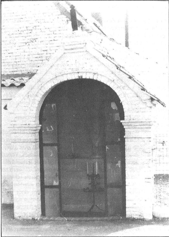
H. Amanduskapel. Sedert het aanbrengen van een nieuwe straatverharding staat de kapel 20 cm onder de paslijn.
